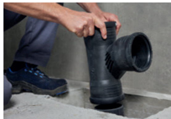
Ein Abwassersystem mit Geberit Silent-Pro SuperTube wird zusammen gesteckt.
