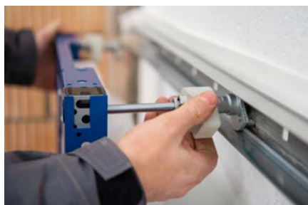
↑ Schritt 3: die System-Wandanker einfach in die Systemschiene eindrehen.
