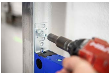
↑ Schritt 3: die seitliche Befestigungslasche ausziehen und festschrauben.
