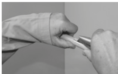
Abbildung 30: Schlitzzen des Kunststoffmantels
