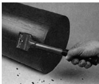
Die Rohroberfläche muss im Bereich der Elektromuffe ca. 10 cm geschabt werden. Der Grat ist zu entfernen.
