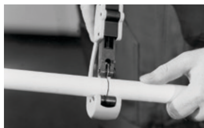
Abbildung 28: Ablängen mit Rohrschneider
