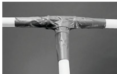
Abbildung 43: Fertig angebrachte Korrosionsschutzbinde
