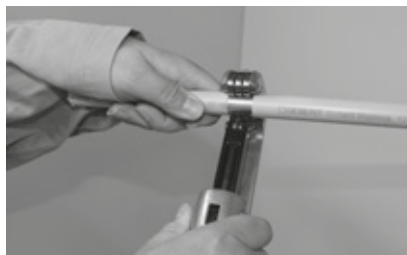
Abbildung 31: Trennen des Rohres bei entferntem Kunststoffmantel
