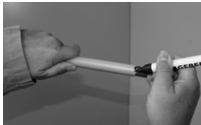
Abbildung 33: Markieren der Einschubtiefe bei Verwendung eines Mapress Abmantelgeräts bei Gasleitungen
