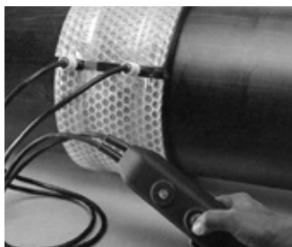
Muffe aufschieben, (Einstecktiefe: 7,5 cm) Die Achsen der Schweißenden müssen genau übereinstimmen. Die Leitung muss während der Schweißung spannungsfrei gehalten werden.
