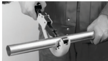
Abbildung 20: Ablängen mit Rohrschneider
