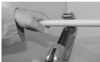
Abbildung 29: Anritzen des Kunststoffmantels
