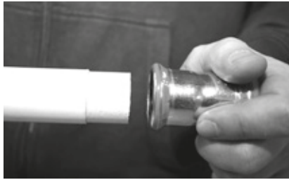
Abbildung 37: Ineinanderschieben von Systemrohr und Pressfitting
