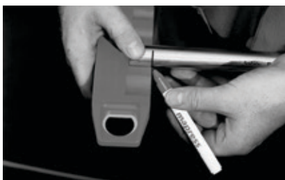
Abbildung 24: Markieren der Einschubtiefe mit Einschubtiefenlehre
