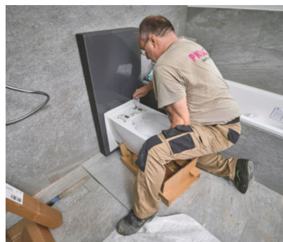
→ Installateur Philippe Kunz ersetzt das bodenstehende WC mit einem modernen Geberit Dusch-WC AquaClean Tuma.
