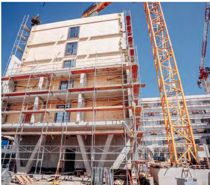
↑ In Sachen Bauzeit setzt die Holz-Hybrid-Bauweise dank des hohen Vorfertigungsgrads neue Maßstäbe.
