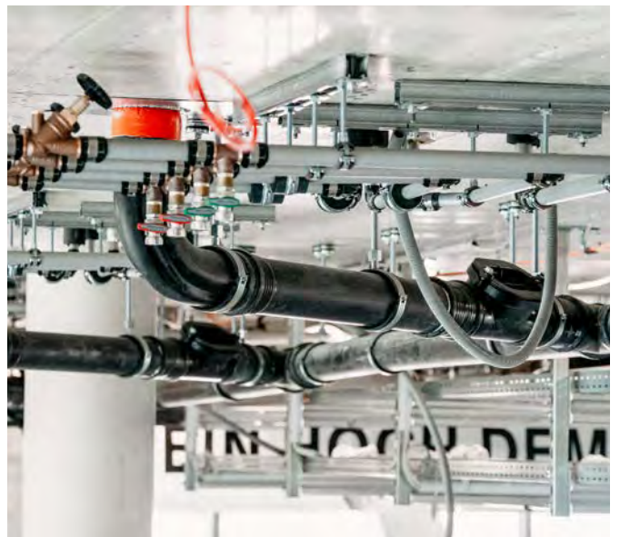
↑ Die Silent-Pro SuperTube-Technologie ermöglicht die Führung der Abwassersammelleitung über 6 Meter ohne Gefälle.
