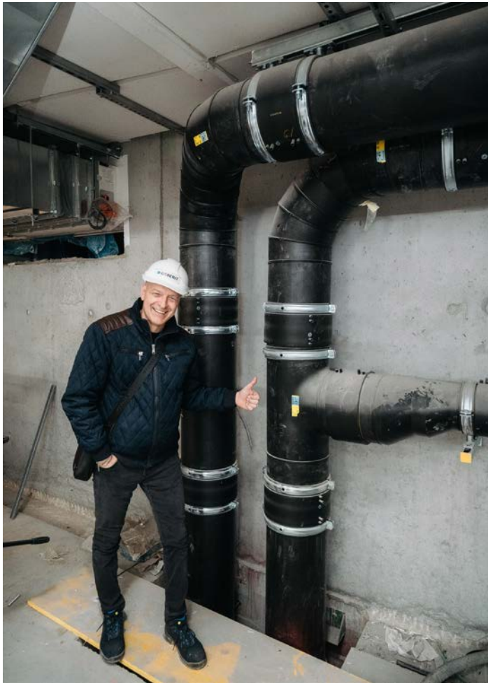
↑ Im Größenvergleich: Rudolf Stieber, Geberit, vor einem PE-Abwasserrohr der Dimension 315.
