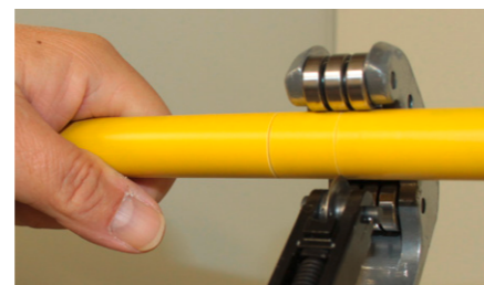
Bild 7: Anritzen des Kunststoffmantels
