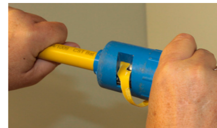
Bild 10: Abmanteln des Kunststoffmantels auf Einschubtiefe
