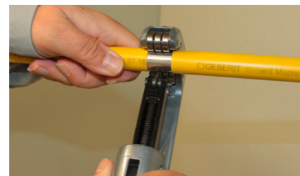
Bild 9: Trennen von Rohr bei entferntem Kunststoffmantel
