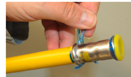
Bild 19: Pressindikator lösen
