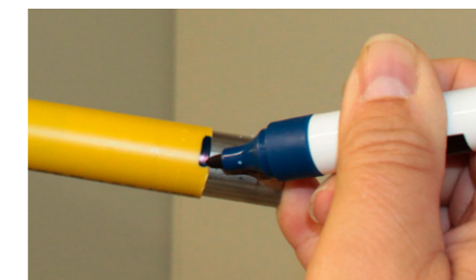
Bild 13: Markierung der Einstecktiefe bei Verwendung von Mapress Abmantelgerät
