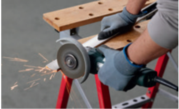
↑ Ablängbare Profile zur Anpassung an verschiedene Bausituationen.
