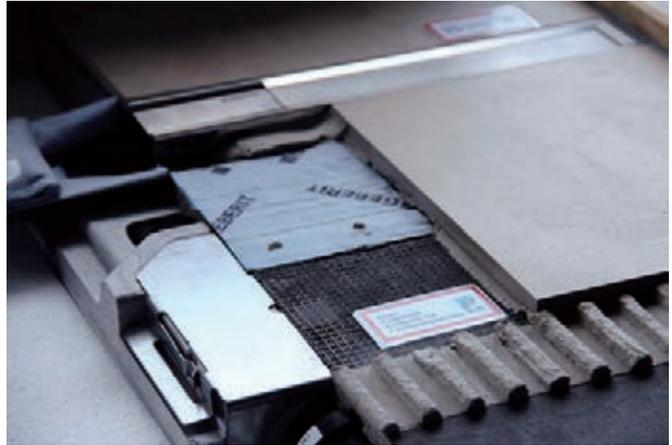
Abbildung 20: Beispiel Geberit Cleanline Grundkörper ohne Estrichüberdeckung mit Materialien der Sopro Bauchemie GmbH.
